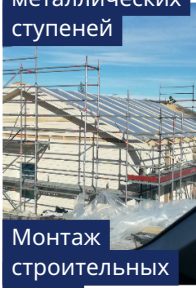
Монтаж каркасных домов
