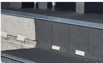
Установка металлического профиля
